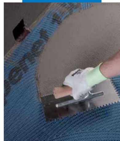
Aplicación de Mapelastic sobre Mapenet 150
