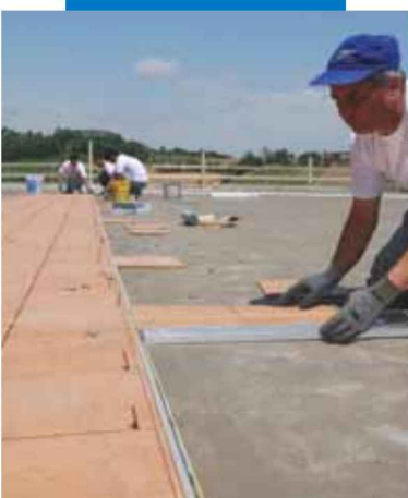
Colocación de cerámica con Kerabond + Isolastic
