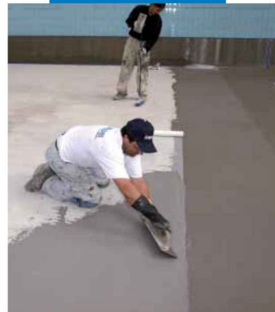
Impermeabilización de una piscina con Mapelastic
