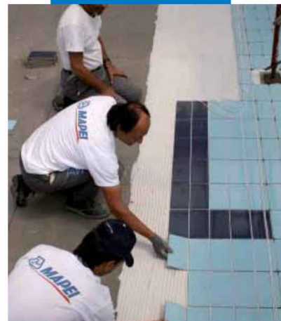
Colocación de revestimiento cerámico sobre Mapelastic
